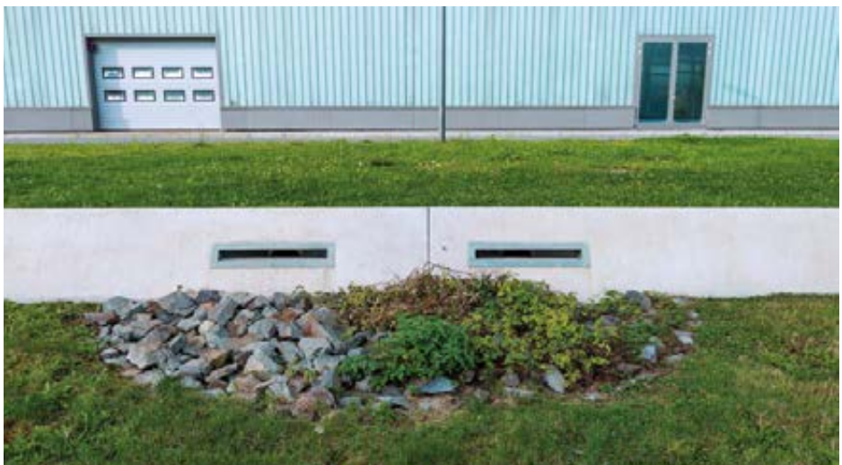
Atos-Gebäude Adlershof, Berlin (Quelle: Andreas [FranzXaver] Süß)
