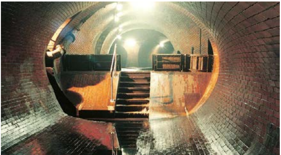
Seestraße, Berlin (Quelle: Berliner Wasserbetriebe)
