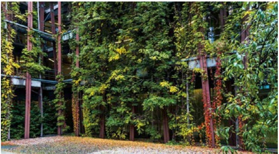
Physikgebäude Adlershof, Berlin (Quelle: Andreas [FranzXaver] Süß)
